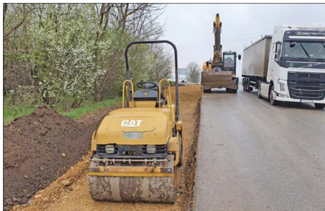
A nagykarácsonyi beágazónál alapozzák az új keresztveződést
