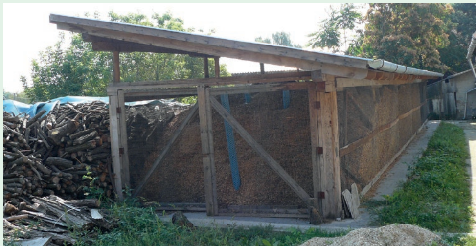
Aprítéktároló biomasszakazánhoz Mezőfalván
